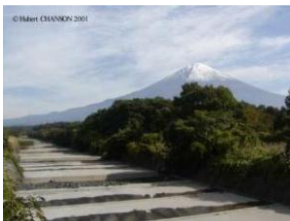
Figura 5 Barreras de retención de rocas
