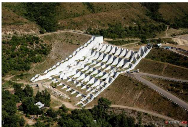
Figura 26 Presa mixta (hormigón y tierra)
