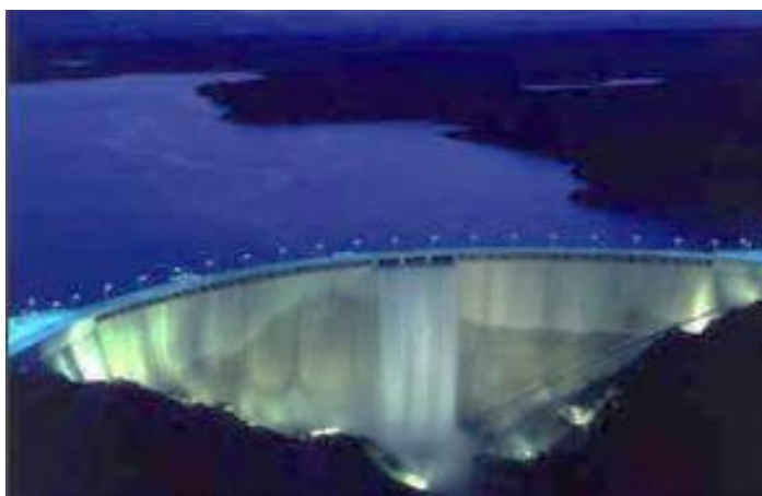
Figura 10 Presa El Atazar
