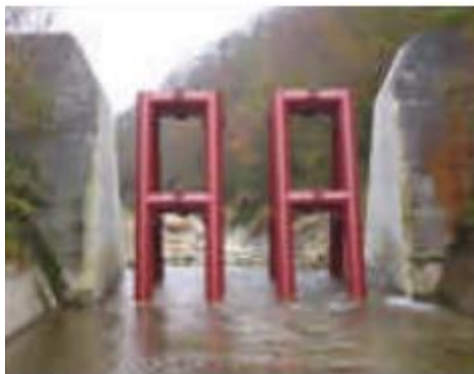
Figura 24 Presa permeable. Uesugi-tani river, Japón.
