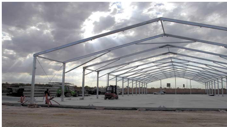
Figura 4: Estructuras de Aluminio
