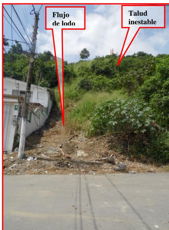
**Figura 79 Flujos de lodo al pie de los taludes.
