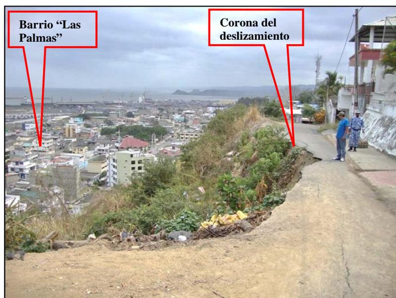
**Figura 77 Erosión retrocedente en la corona del deslizamiento, en el año 2012**
