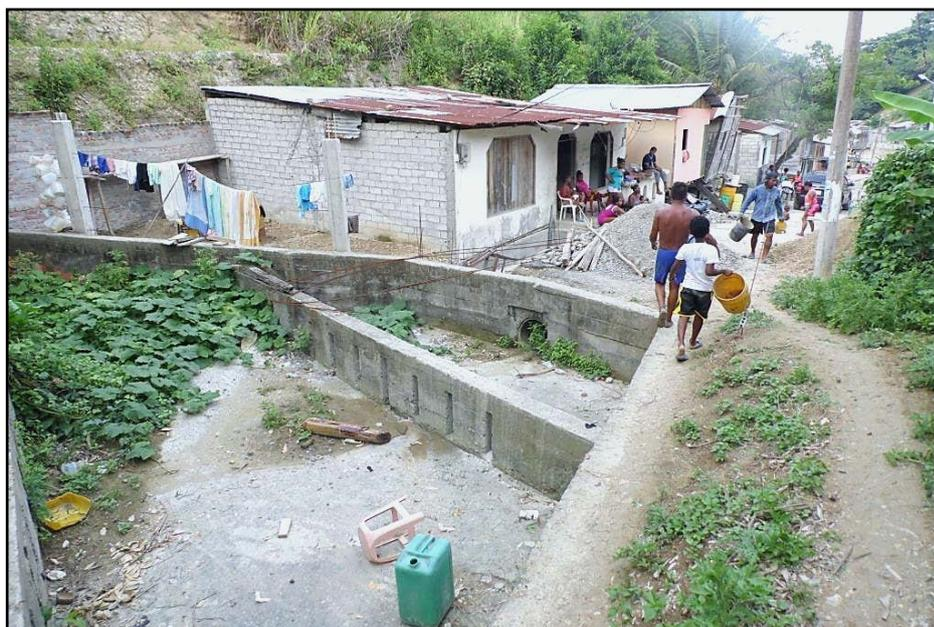
**Figura 70 Trampas de lodo en mal estado. Barrio “El Embudo”, marzo 2017**
