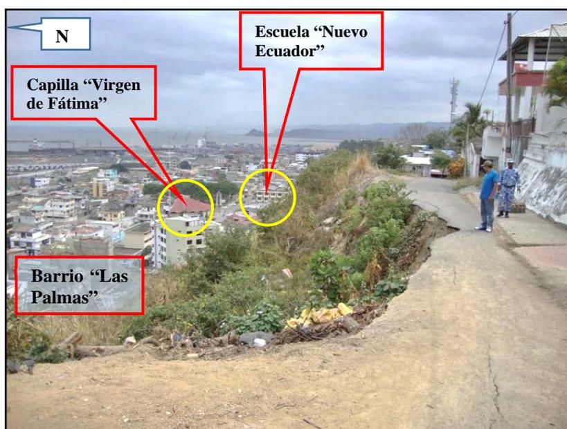
**Figura 63 talud inestable con erosión retrocedente, barrios “Tercer Piso” y "Las Palmas", año 2012**
