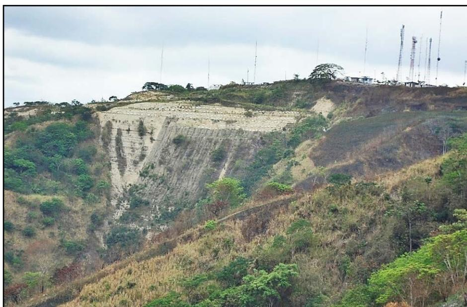
**Figura 72 Estabilización de los taludes en la cima del "Cerro Gatazo", contratada por la SNGR**
