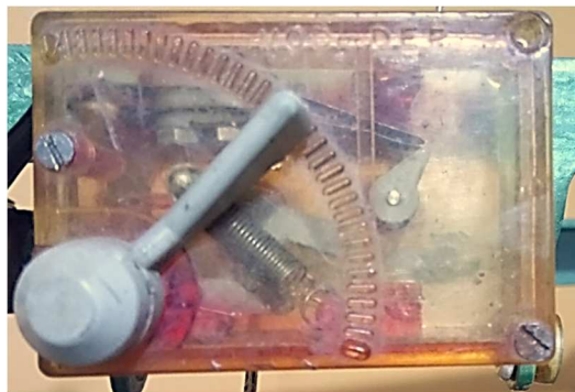
Figura 112 Caja de control para el sensado de nudos y de hilo roto
