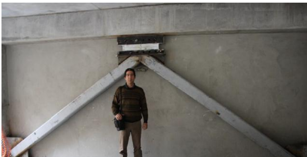
Figura 1 Disipador de energía tipo Shear Link.
