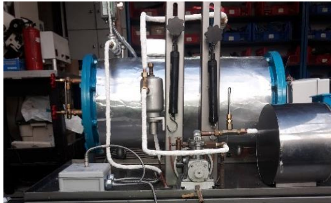
Figura 85 Cañerías de Cobre recubiertas con Yeso
