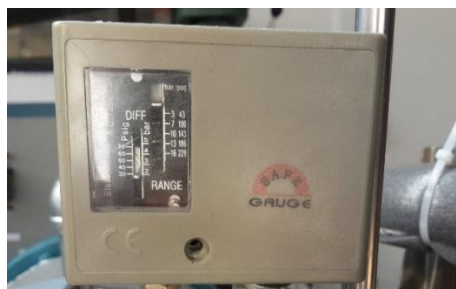
Figura 90 Interruptor de Presión
