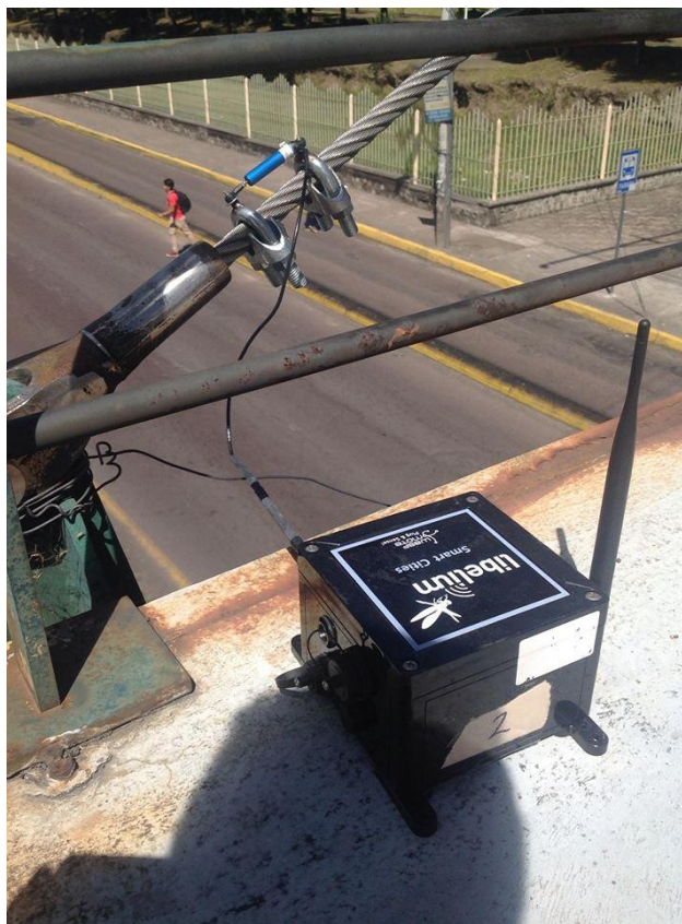
Figura 59 Colocación de deformímetro en cable
