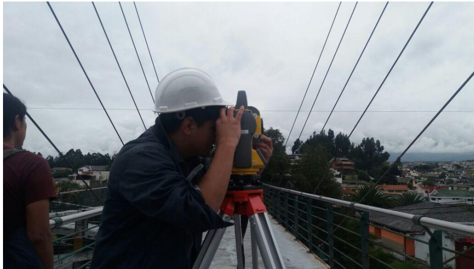
Figura 23 Medición de ángulos de inclinación
