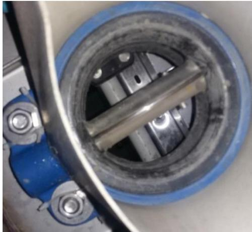
**Figura 56. Actuator rotativo neumático tipo mariposa.**
