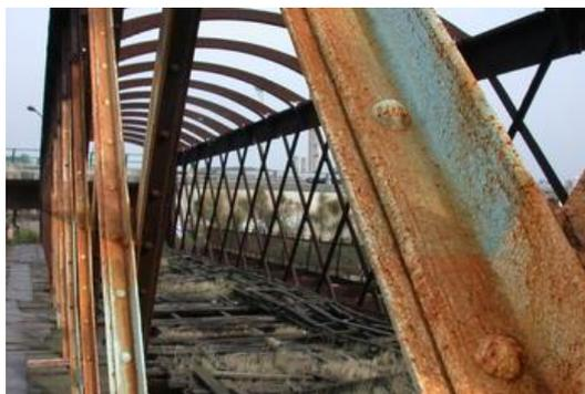
**Figura 9 Corrosión en estructura metálica**
