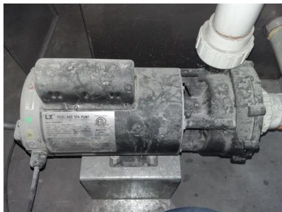
**Figura 40. Bomba de 2HP de potencia**
