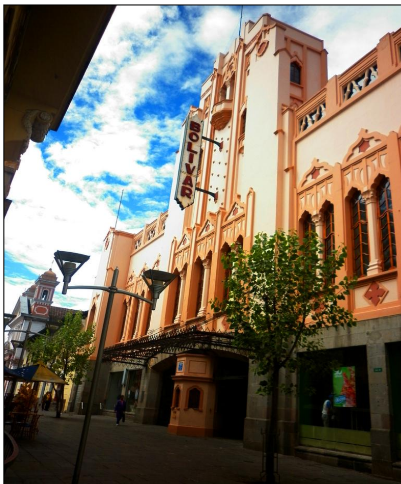
Figura 1 Fachada del Teatro Bolívar Fuente: (Fundación Teatro Bolívar, 2016)
