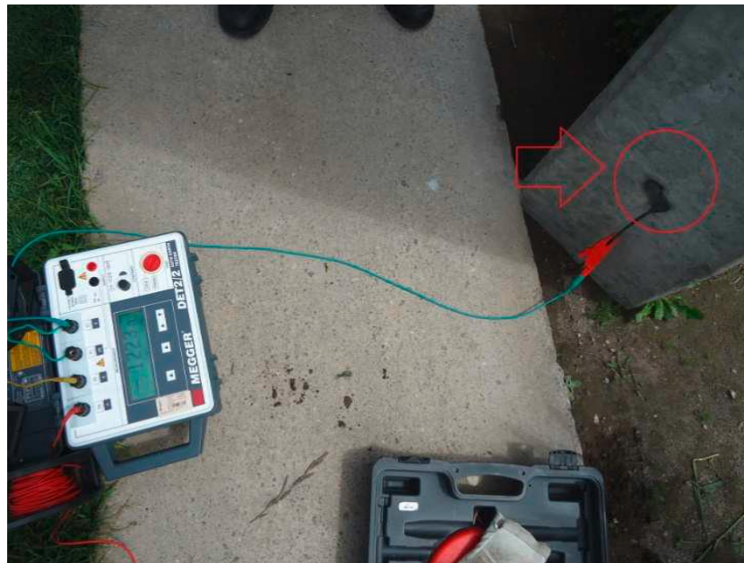
Figura 29 Medición de puesta a tierra
