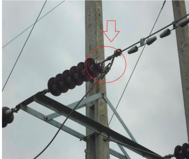
Figura 30 Aislador de suspensión roto
