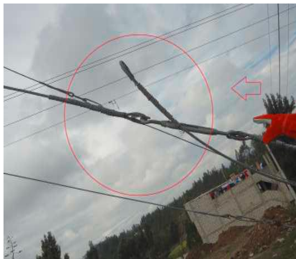
Figura 27 Tensor suelto
