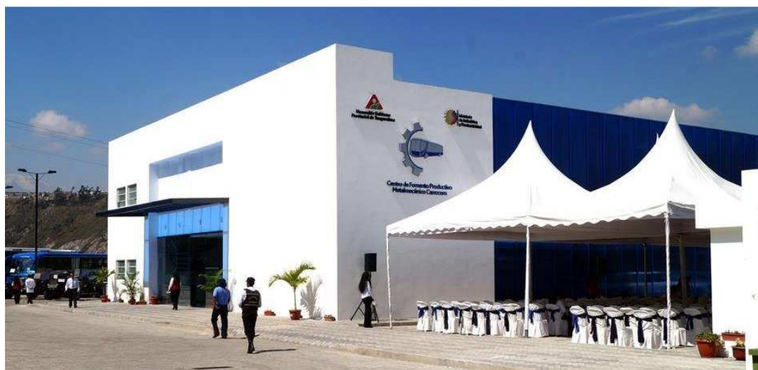
Figura 58 Centro de fomento productivo metalmecánico carrocerero, Ambato.
