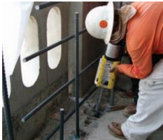
Figura 75 Perforaciones en losa para el traslape de varillas longitudinales del muro
