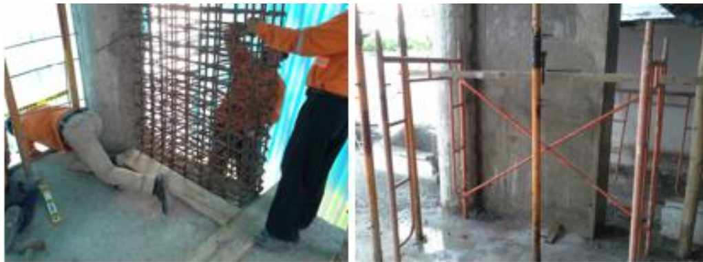
Figura 76 Armado y fundición de muro de hormigón
