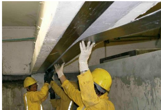
Figura 24 Refuerzo a flexión en vigas con CFRP
