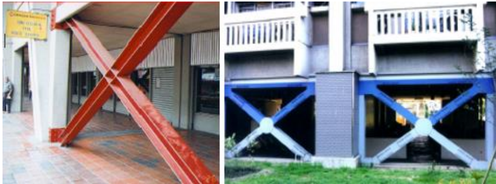
Figura 27 Estructuras reforzadas con diagonales de acero
