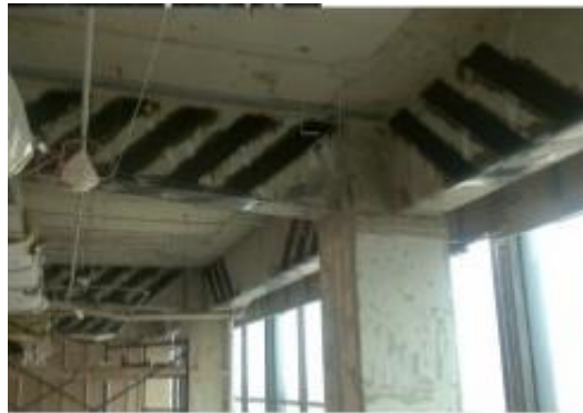
Figura 26 Refuerzo a torsión en vigas con CFRP
