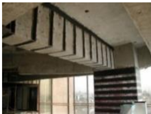
Figura 25 Refuerzo a corte de vigas con CFRP
