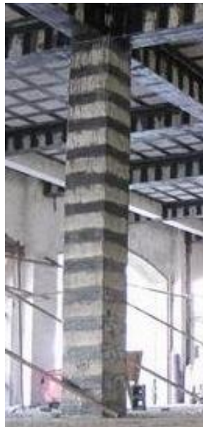
Figura 77 Fibras de carbono para reforzamiento a corte
