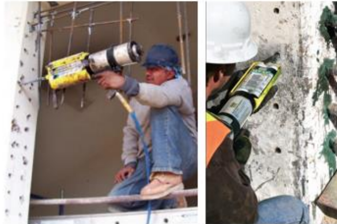
Figura 74 Perforaciones en columna para anclaje de acero transversal en muro
