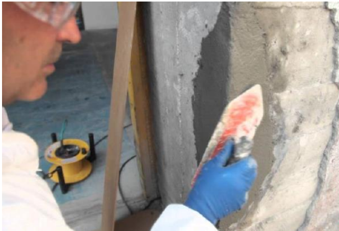
Figura 78 Reparación de columna
