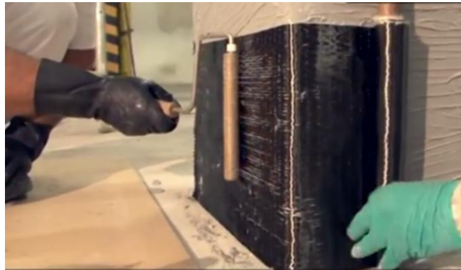
Figura 79 Colocación de fibra de carbono en columna
