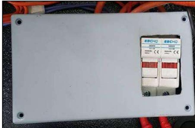
**Figura 68. Módulo de conmutación del positivo**
