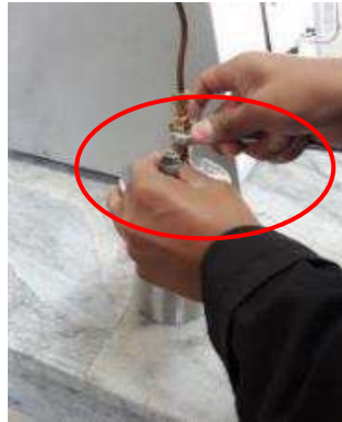
Figura 19. Conexión de la cañería de llenado de oxígeno
