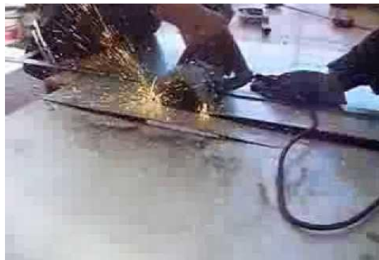
Figura 108 Corte de material
