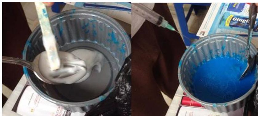
Figura 86 Colocación parte A y B en envase para mezclar
