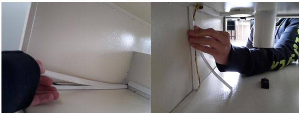
Figura 118 Colocación de canaletas plásticas
