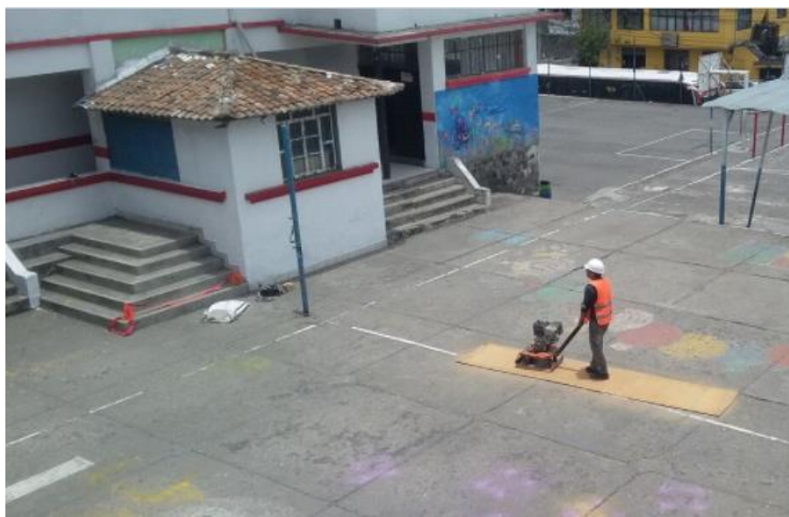
Figura 88: Vibro compactadora encendida orientada al eje X.
