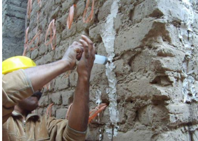
Figura 43: Inyecciones de lechada Fuente: (PUCP, 2017)
