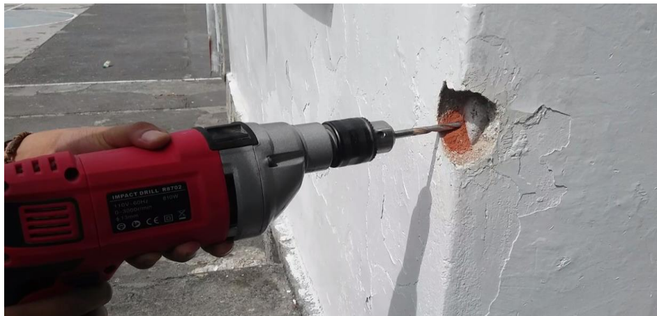
Figura 76: Columna de mampostería
