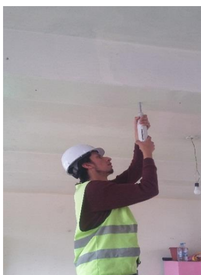
Figura 71: Ensayo esclerométrico en una viga.
