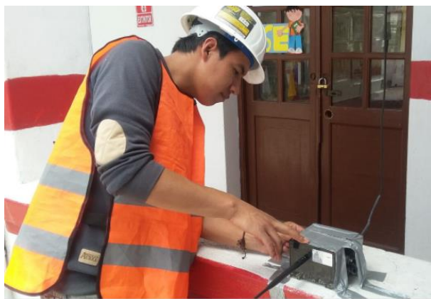
Figura 87: Aseguramiento de los acelerómetros a la estructura
