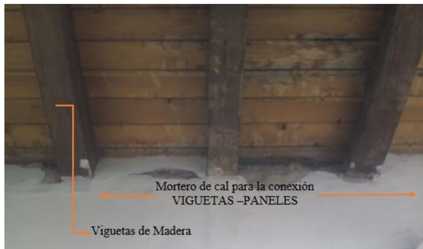
Figura 100: Configuración y estado del entrepiso de la edificación
