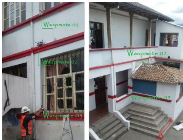
Figura 83: Ubicación de los acelerómetros en la estructura
