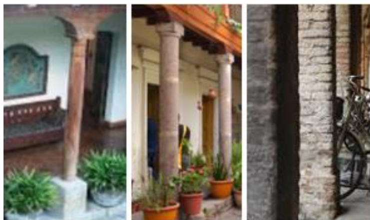
Figura 8: Columnas en edificaciones antiguas
