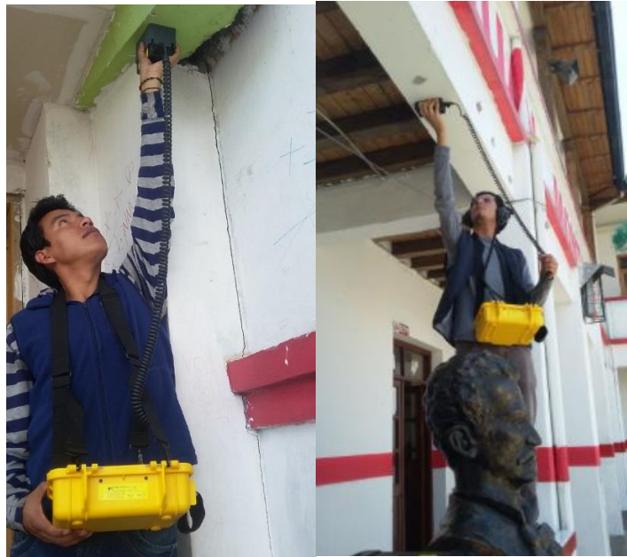
Figura 74: Localización del acero de refuerzo
