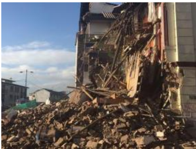
Figura 3. Estructura mixta colapsada tras un sismo Fuente: (El Comercio, 2017)
