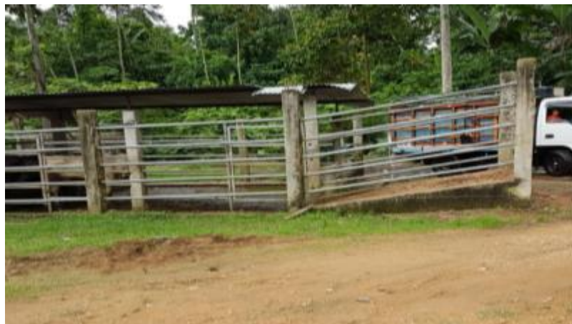
Figura 26 Camal Puerto Quito no tiene estructura adecuada para lavado de vehículos
