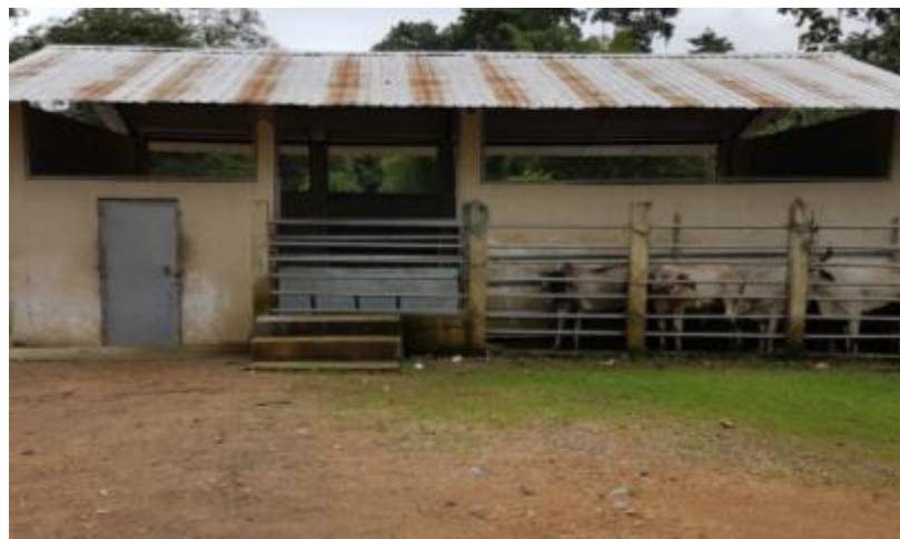
Figura 30 Camal Puerto Quito sin sala de emergencia para bovinos
