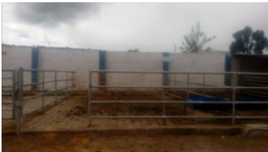
Figura 28 Camal Cayambe no cuenta con instalaciones de lavado de vehículo
