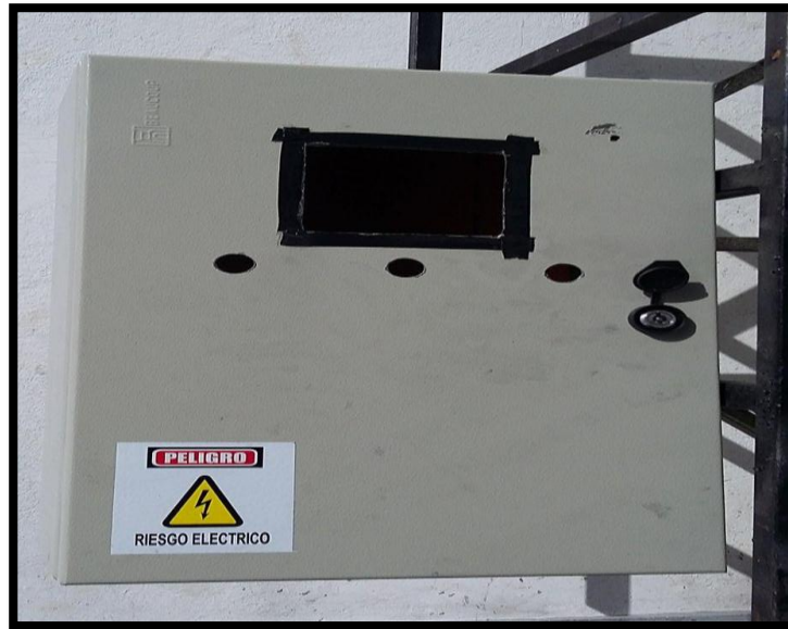
Figura 66. Tablero de control en construcción
