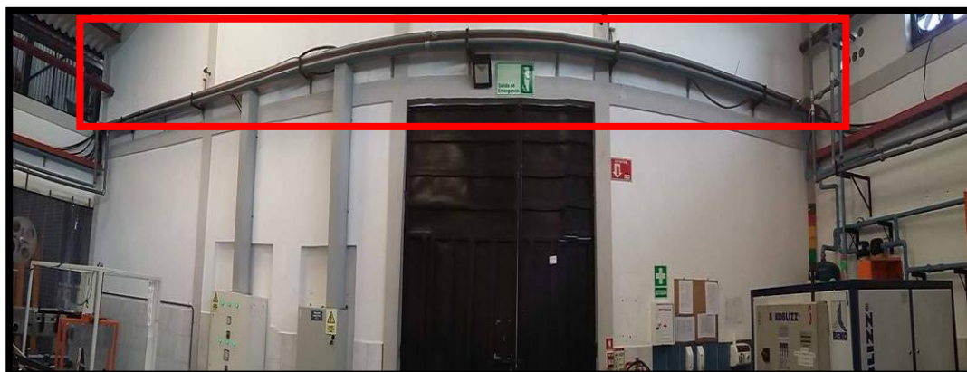
Figura 63. Montaje de la tubería en el área de producción
