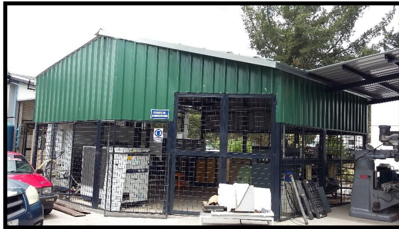
Figura 69. Cuarto de máquinas - parte exterior
