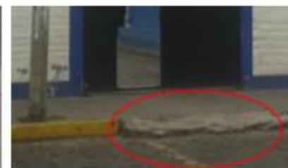
**Figura 401 Vado vehicular en mal estado**
