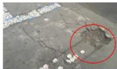
**Figura 400 Vado vehicular con el piso fisurado y roto**
