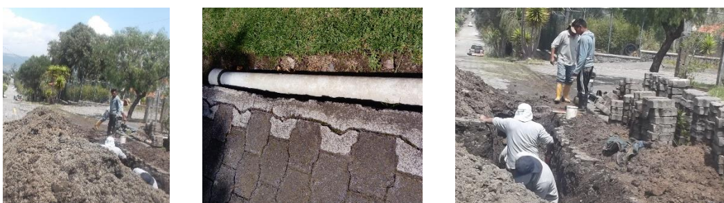
Figura 55. Reparaciones en redes de agua potable
