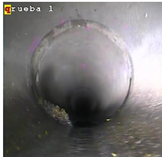
Figura 101. Desgaste de paredes y juntas
