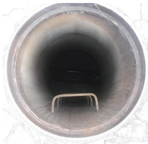
Figura 93. Estado de los componentes de los pozos de revisión
