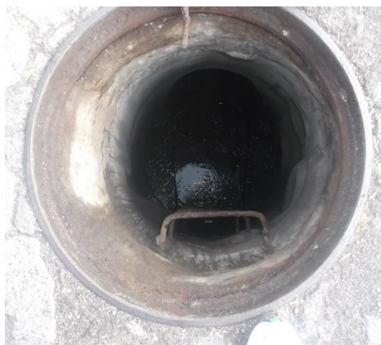
Figura 94. Estado de los componentes de los pozos de revisión
