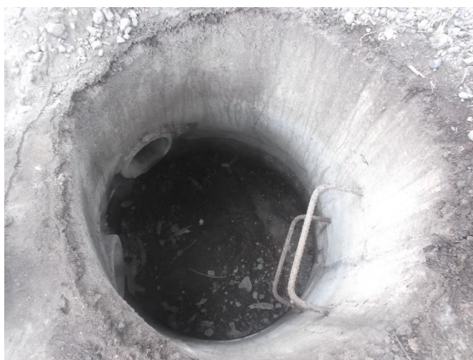
Figura 95. Estado de los componentes de los pozos de revisión
