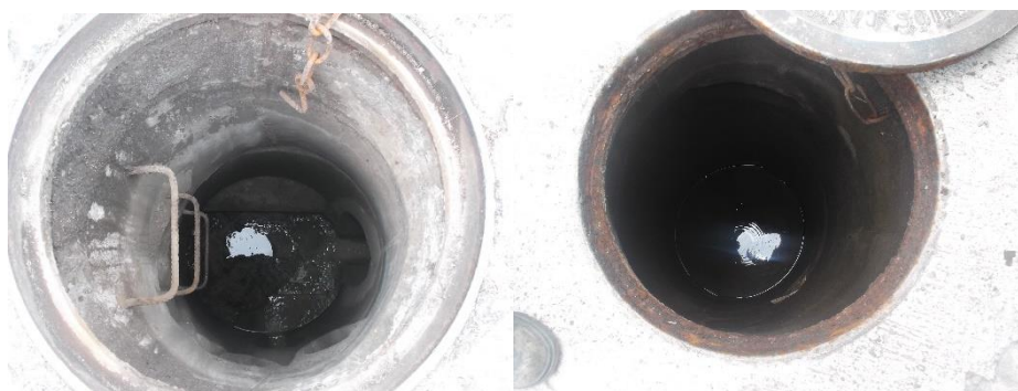
Figura 91. Pozo con escalera y sin escalera
