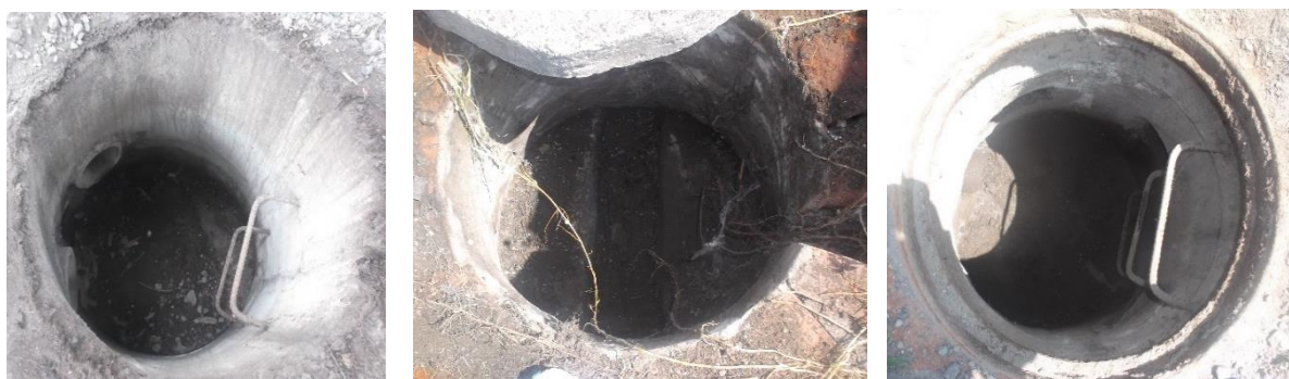
Figura 89. Condiciones de sedimentación en pozos de revisión
