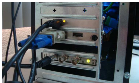
Figura 71. Instalación de la tarjeta
