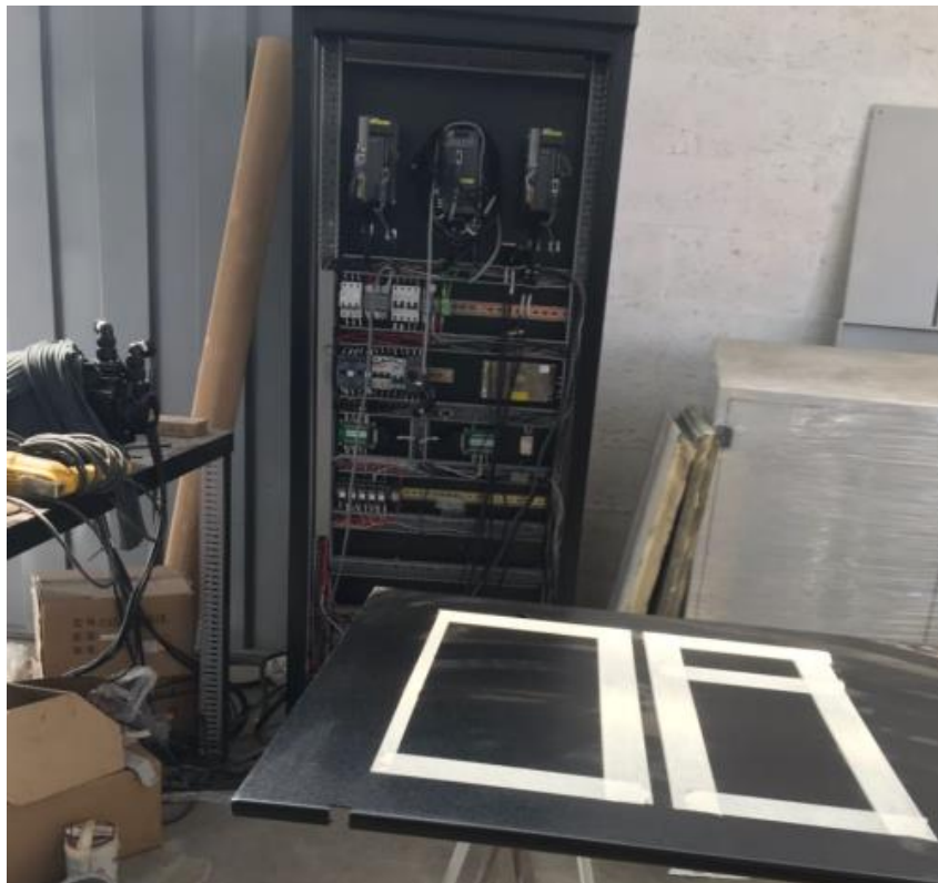
Figura 29 Construcción del nuevo tablero de control
