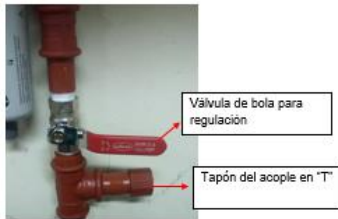
Figura 41 Válvula de bola y acople en "T"
