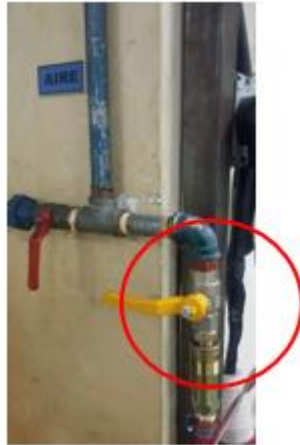
Figura 36 Válvula de bola (paso del aire del compresor)
