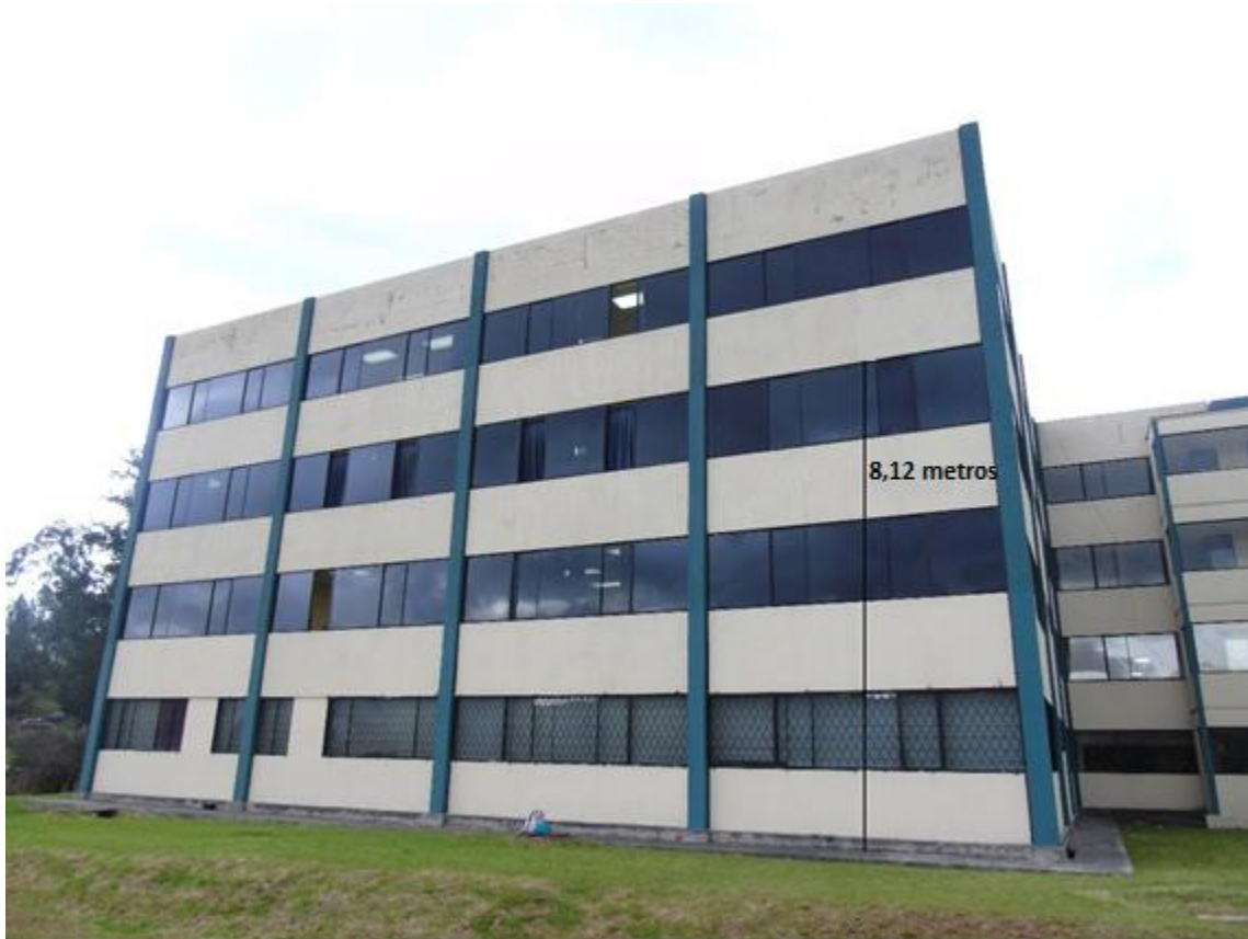
Figura 54 Altura tercer piso
