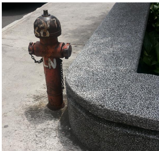
Figura 26 Salida de Red Seca
