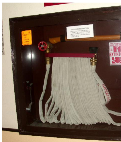
Figura 25 Red Húmeda del edificio
