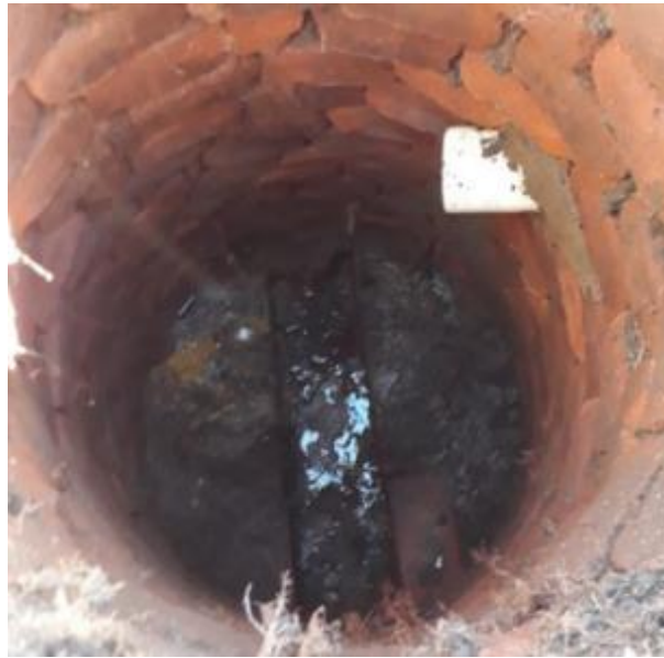
Figura 12. Pozo de ladrillo con acometida domiciliaria
