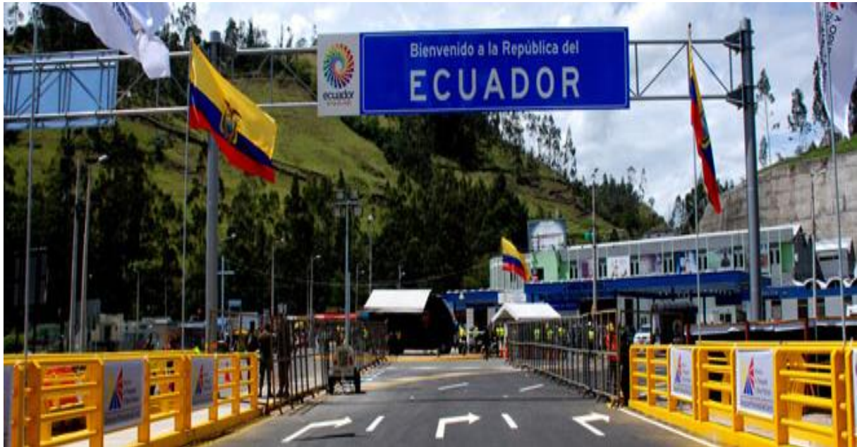
Figura 42. Puente internacional Rumichaca FUENTE: La Republica
