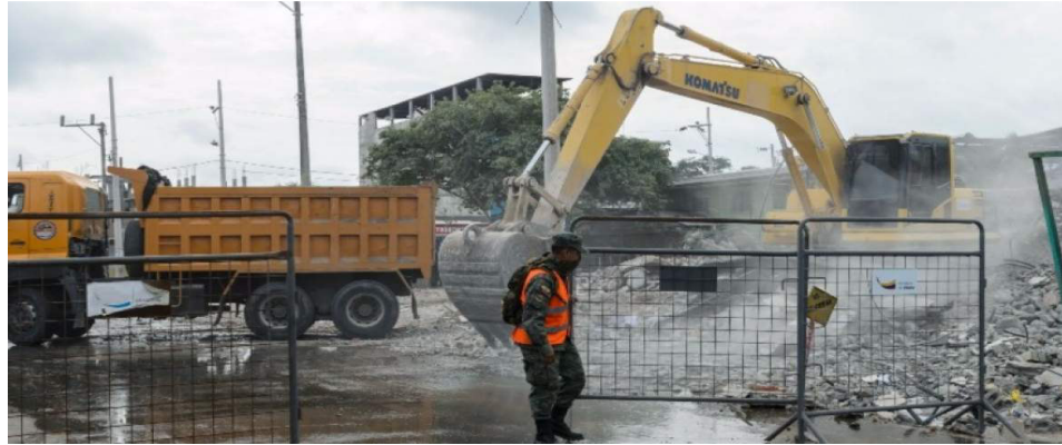
Figura N° 8: Removimiento de escombros
