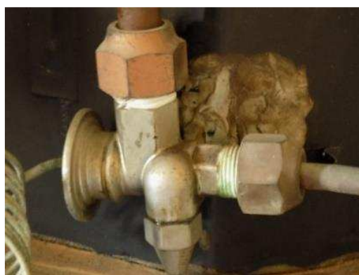
Figura 11 Válvula de expansión termostática
