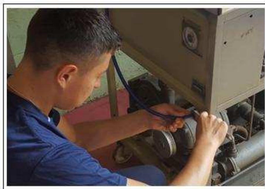
**Figura 24:** Instalación de manguera en entrada de gas.
