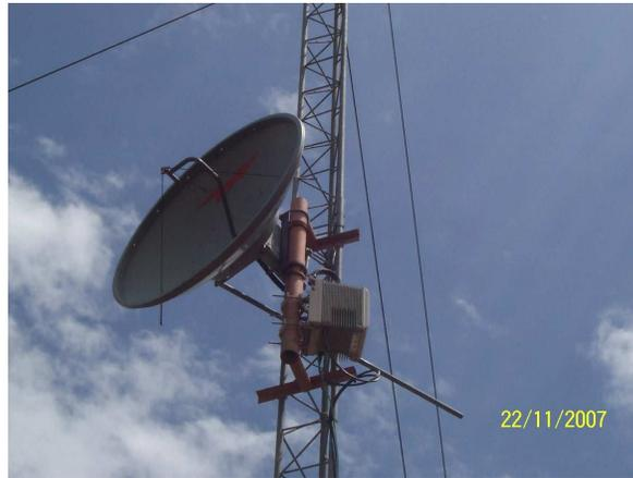
Figura. 3.15. ANDREW® HP2-130 (San Rafael)<sup>[18]</sup>Tabla. 3.15. Radio microondas enlace Laboratorio de Geología – C. Pichincha<sup>[5]</sup>
