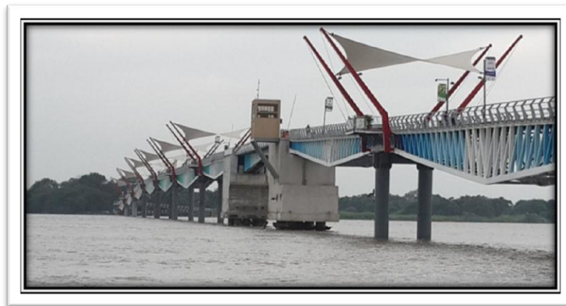
Figura 2.3 Puente Basculante Santay, Vista Lateral
