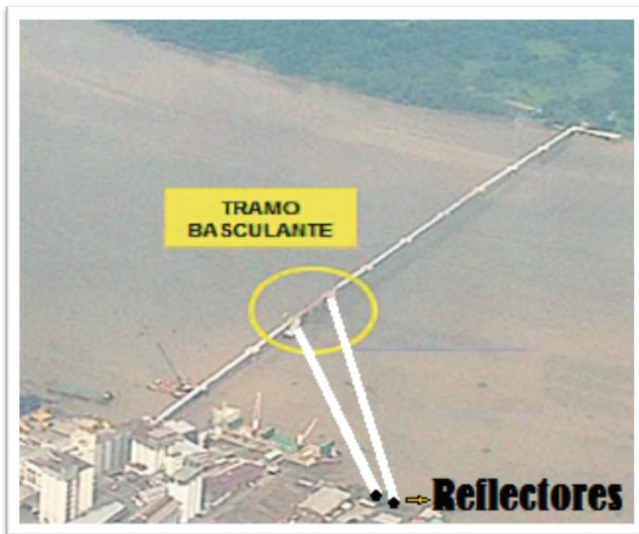
Figura 4.5 Reflectores Alumbrando los Pilares
