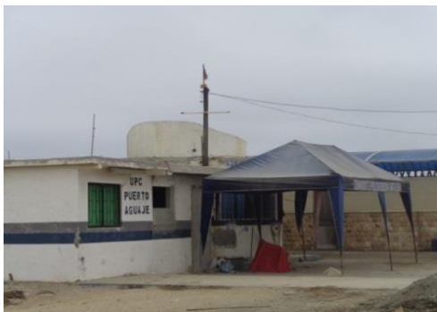
Figura 3.7 Puesto de Control FUENTE: Playa Punta Carnero, 2014 Elaborado por: Autor
