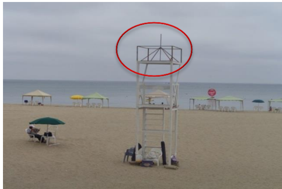
Figura 3.13 Casetas de salvavidas actuales en Salinas FUENTE: Playa Chipipe, 2014 Elaborado por: Autor
