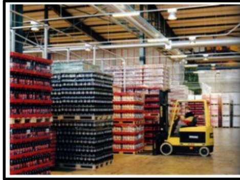
Figura 2.6.1: Iluminación General Fuente: http://maresa.com/
