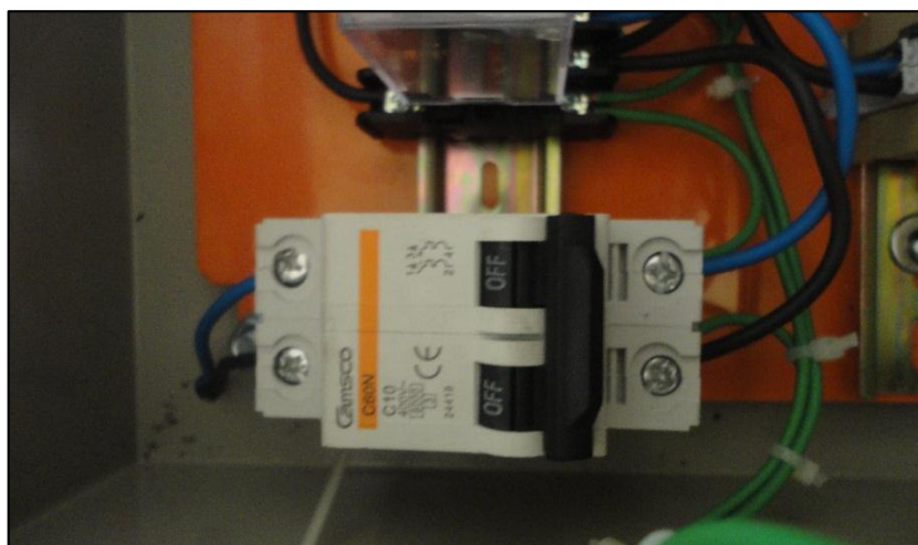
Figura 4.4 Disyuntor o breaker
