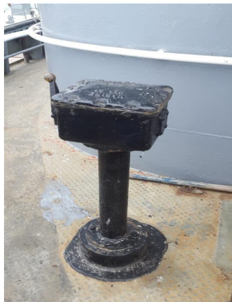
Figura 2.22 Control y mando eléctrico del cabrestante.
