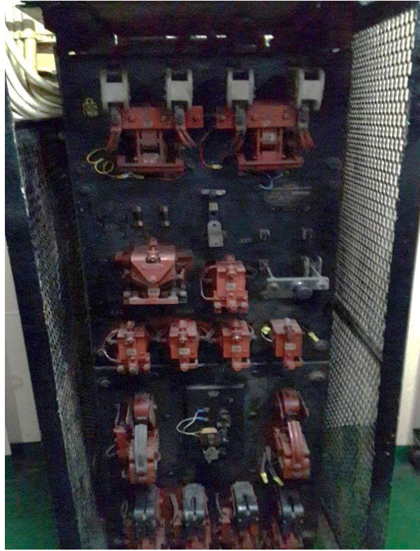
Figura 2.21 Sistema de arranque del motor de corriente continua
