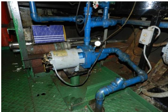
Figura 2.5 Bomba de agua de bebida del BAE Marañón
