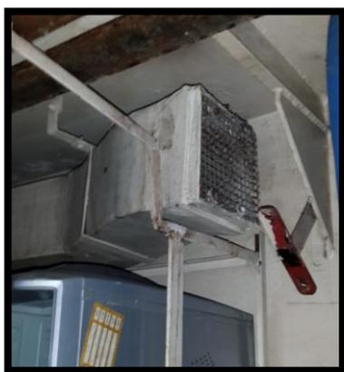
**Figura 4.2 Ductos de ventilación, pañol de maletas.**
