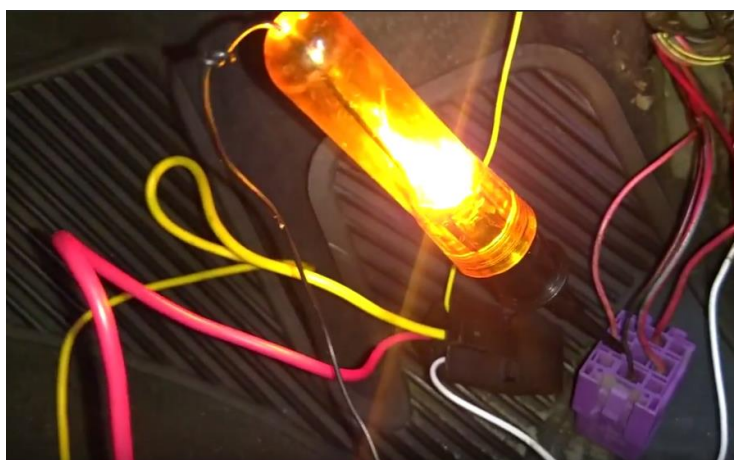
Figura 36 Detección cable de bloqueo
