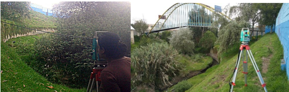
Figura 3. Levantamiento topográfico para el puente vehicular en la calle Gabriel Álvarez
