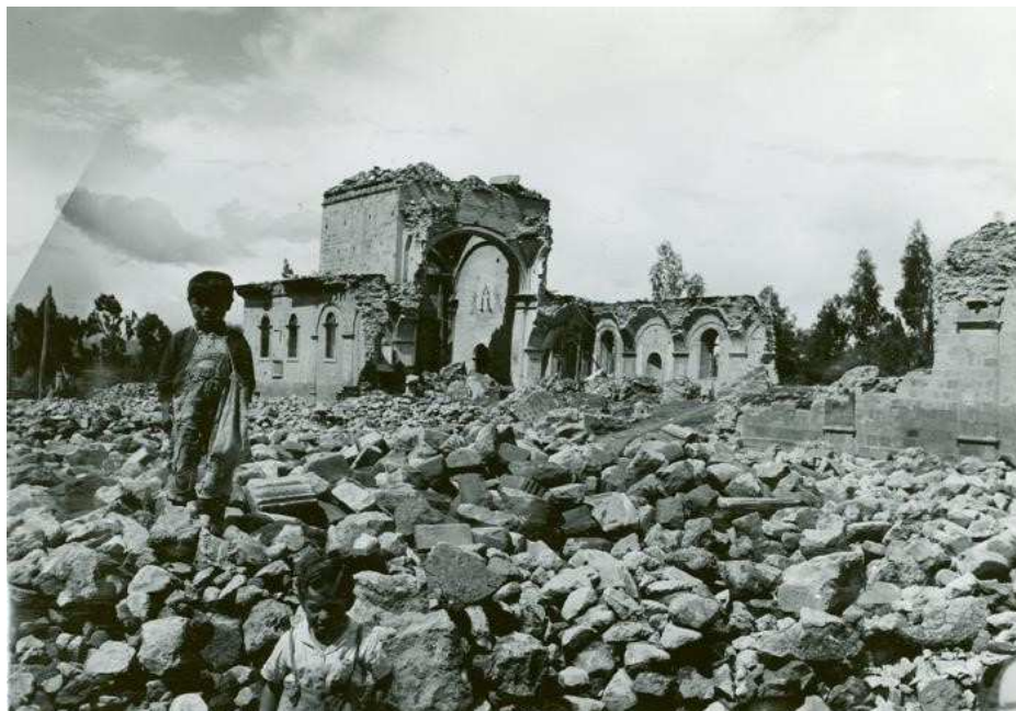
Figura 8 Ruinas de la Iglesia de Santa Rosa, provincia de Tungurahua Fuente: USGS
