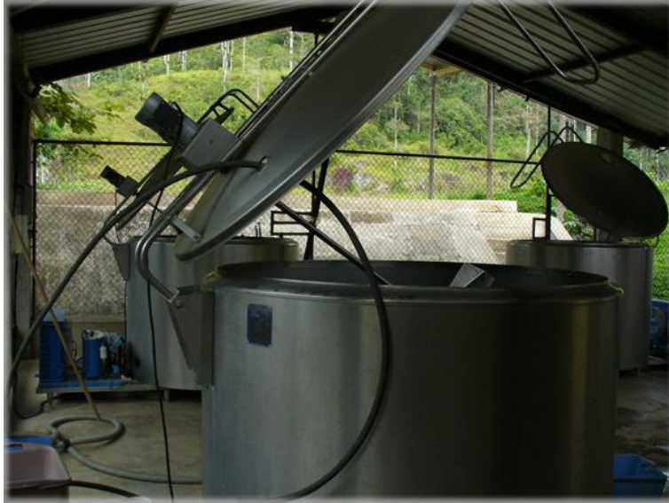
Tanque de frio
