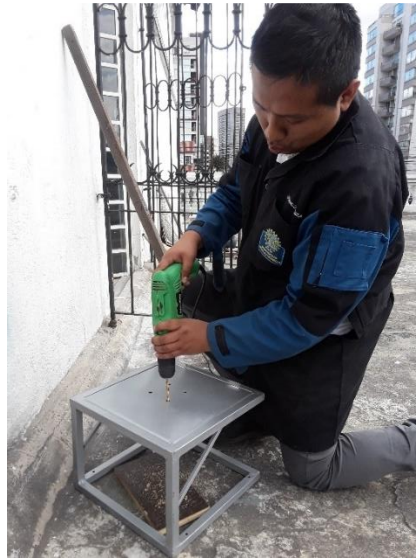
Figura 79 Preparación de la base antes de montar el robot
