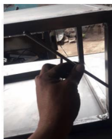
Figura 78 Colocación de ángulo de refuerzo
