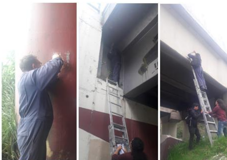
Figura 80. Ensayo Esclerómetro Pila P3 (izq.), Tablero (cent.) y Viga H.P (der.).
