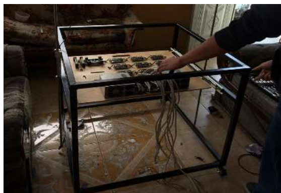
Figura 70. Ubicación del tablero electrónico.
