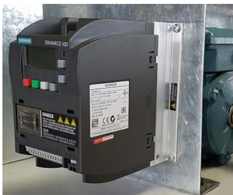
Figura 45. Montaje Variador en Placa L
