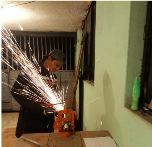
Figura 93. Corte de los tubos
