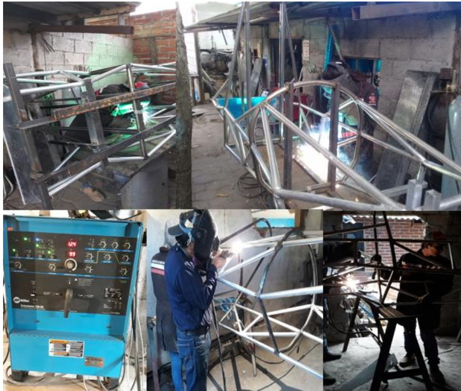
Figura 104. Proceso de soldadura TIG.
