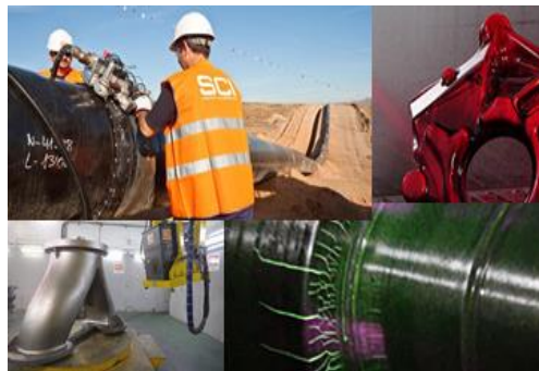
Figura 42. Ensayos no destructivos.
