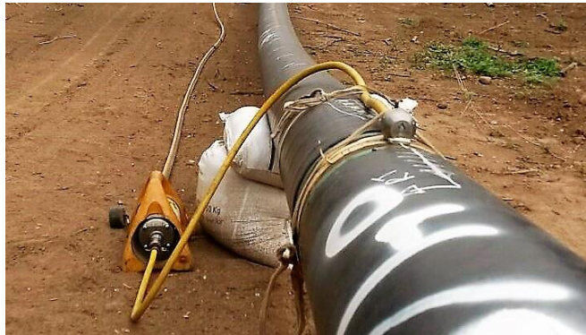
Figura 46. Proceso de Radiografía Industrial
