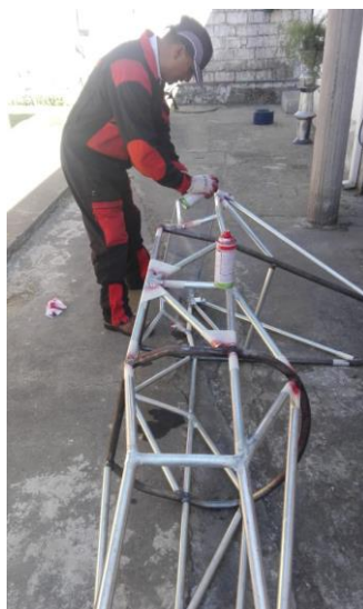
Figura 108. Inspección Visual realizada por el Ing. Julio Vera
