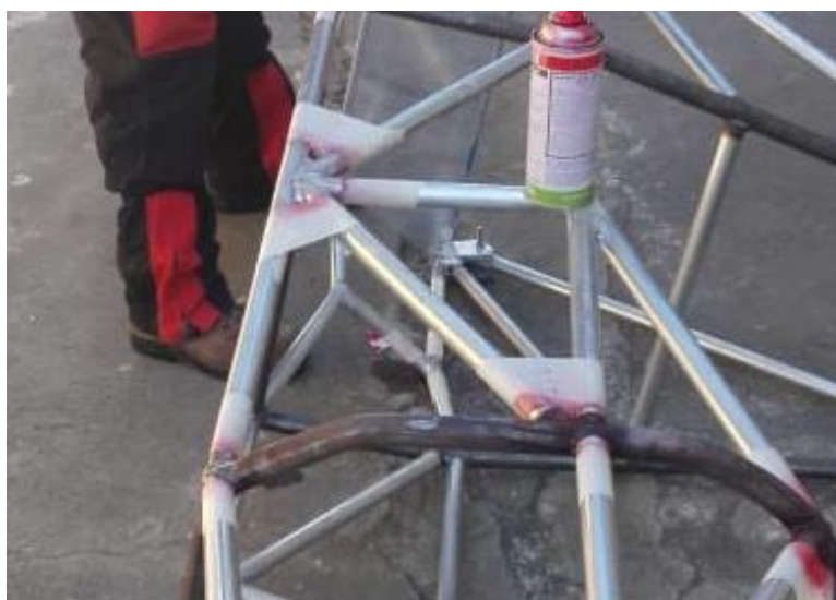
Figura 111. Aplicación de paños
