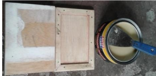
Figura 64. Aplicación cera desmoldante
