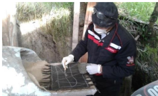
Figura 107. Aplicación del material compuesto M2
