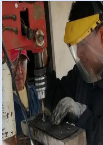
Para la construcción de las placas de sujeción se realizó cortes rectangulares de 230 x 100 mm, los mismos que constan de 6 perforaciones que serán usados por los expansores de  $\frac{1}{2}$  pulgada los mismo que se instalarán para la sujeción de los raíles con el techo del geriátrico.
