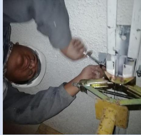
Verificado el correcto ajuste y acople del techo a los rieles del sistema, se procedió a montar el carro móvil y comprobar si este seguía la trayectoria construida.
