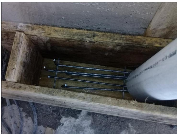
**Figura 47** Encofrado
